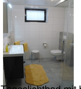
Tageslichtbad mit bodentiefer Dusche
